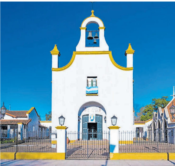
Fachada. La iglesia sufrió cuatro destrucciones hasta la actual.
